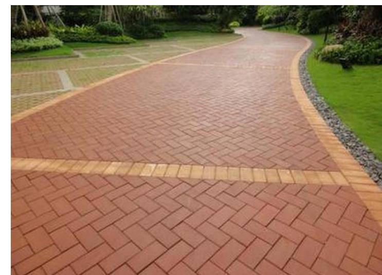
图 8-32 棚户区改造后渗透铺装示意图
