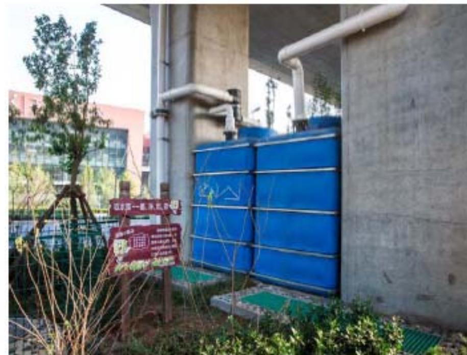
图 7-58 高架雨水收集至桥下蓄水设施
